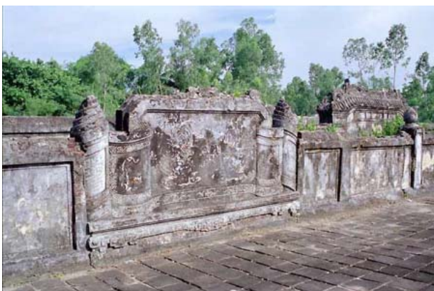
Tombeau de Duc Duc – mur d'enceinte
